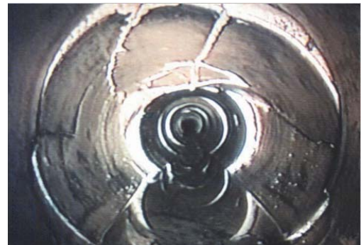
下水道管内の状態を点検・調査
