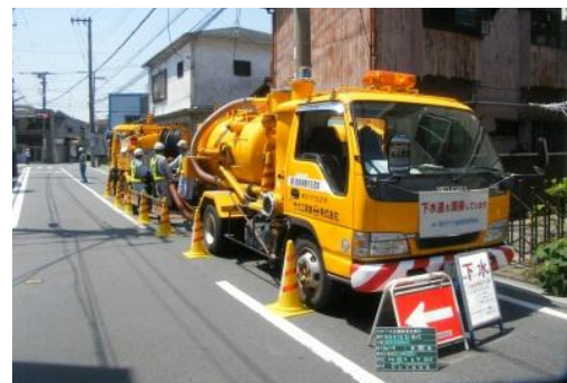
吸引車による下水道管の清掃
