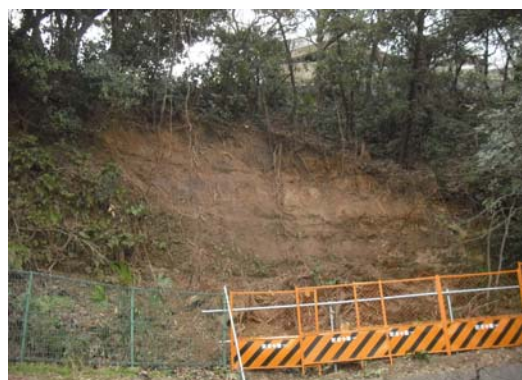
安全対策が必要な斜面地
